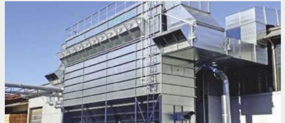
Diesen Filter mit einer Luftleistung von 175.000 m<sup>3</sup>/h errichtete Scheuch LIGNO für das Ladenburger Schicht-Holz (LSH).
